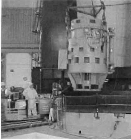
写真6 再循環ポンプモータの 解体撤去
