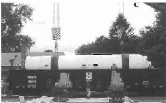
写真5 加圧器の輸送作業 (貨車への積付け)
