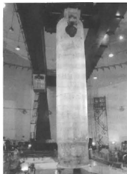
写真4 加圧器の解体撤去
