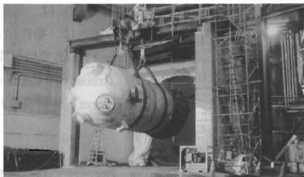
写真2 (上) 蒸気発生器下部胴の搬出
