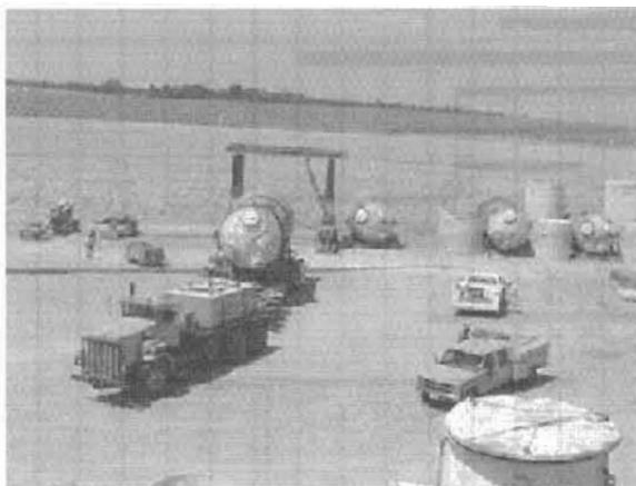
写真3 バーウウェル処分場に運ばれた 蒸気発生器 (下部胴)
